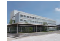
技術開発交流センター (5号館)
