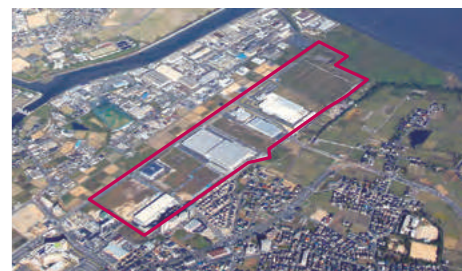
8 北九州空港跡地産業団地
