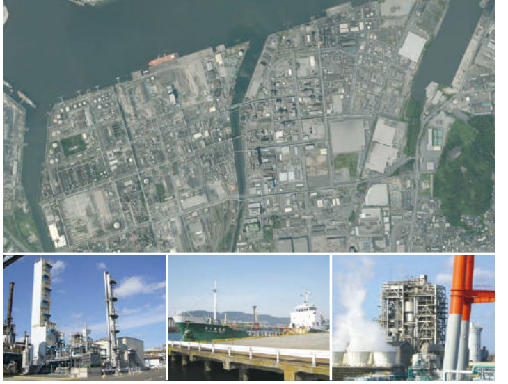
工業ガス製造設備
