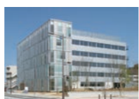
事業化支援センター (4号館)
